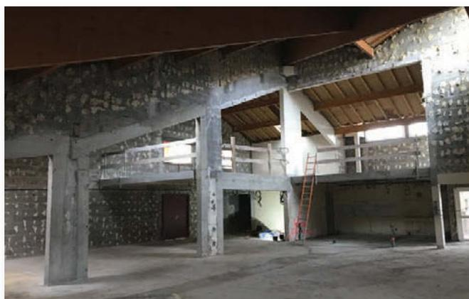
Après plusieurs chantiers de désamiantage, les travaux de démolition des cloisons intérieures de la salle polyvalente ont pu être réalisés et le gros œuvre pratiquement terminé pour les congés de Noël. Les
