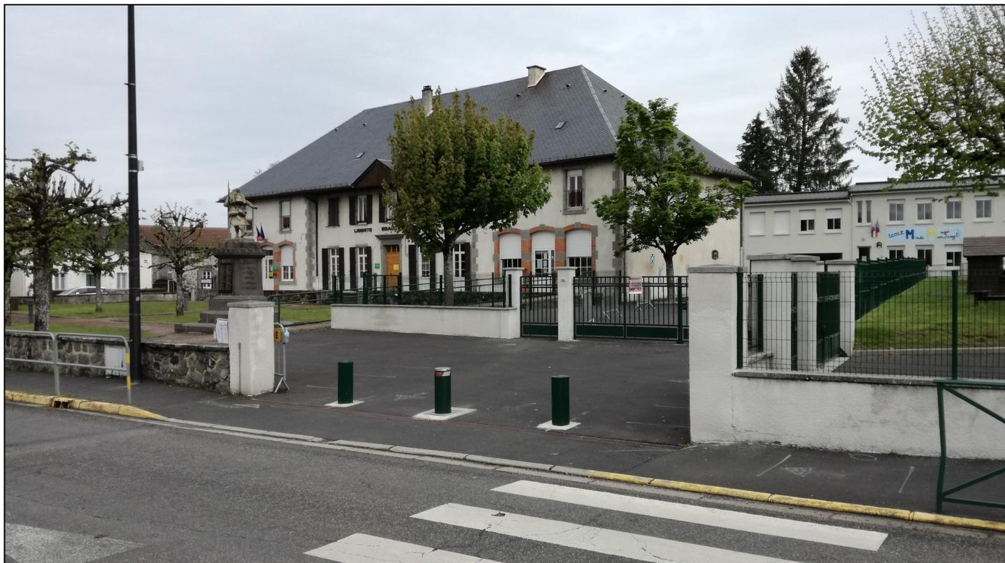
**Sécurisation de l'école :** rehaussement des différents grillages cintrant l'école, pose de bornes anti-encastrement, mise en place de nouvelles fermetures, démolition du muret séparant l'école du parc de la mairie.
